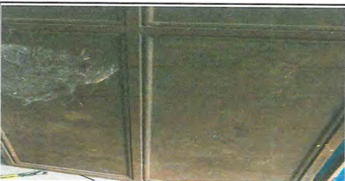
Foto 5: Puertas en mal estado
